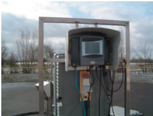
FIGUUR 7 FOSFAATMETER, GEÏNSTALLEERD BOVENOP HET DEK VAN DE ACTIEFSLIBTANK OP DE RWZI TE DEVENTER
