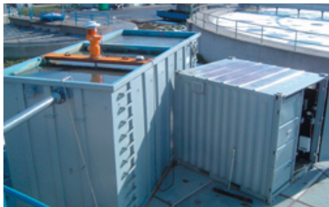
PROEFINSTALLATIE OP DE RWZI TE DEVENTER
