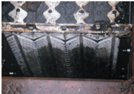
REINIGEN LAMELLENFILTER M.B.V. ZUIGAUTO (LINKS) EN EEN LEEG GEZOGEN VOORZIENING (RECHTS)
