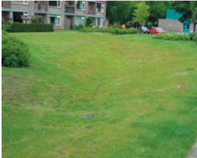
FIGUUR 7.10 WADI TER KLEEF, ALMELO NA HET TOEPASSEN VAN DE VERBETERINGEN
