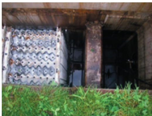
REINIGEN LAMELLENFILTER M.B.V. ZUIGAUTO (LINKS) EN EEN LEEG GEZOGEN VOORZIENING (RECHTS)
