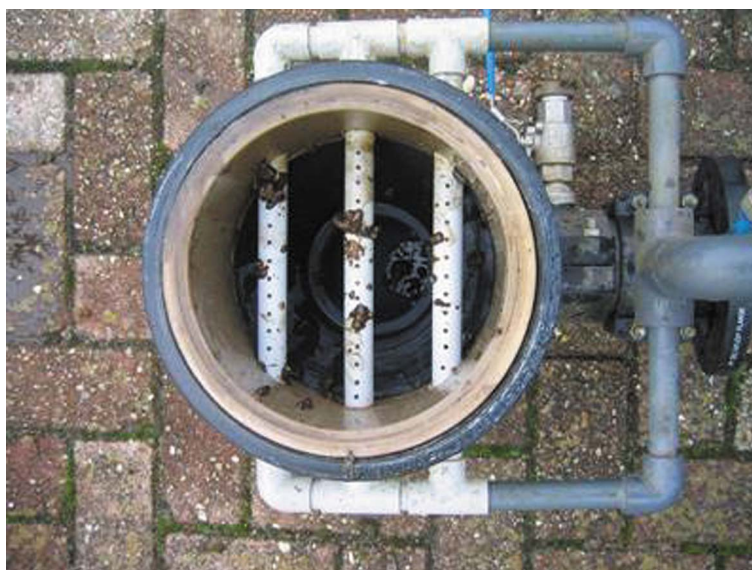
FIGUUR 42: VERSTOPTE GAATJES IN BELUCHTINGSCHOTELS VAN DE MEMBRANEN
