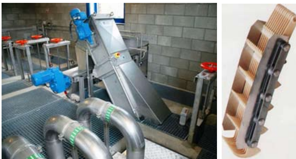
AFBEELDING 5 VOORBEELDEN KETTINGROOSTER [7,8]
