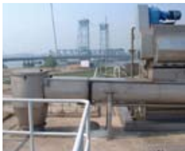
AFBEELDING 22 ROOSTERGOEDVERWIJDERING OP RWZI HOOGVLIET
