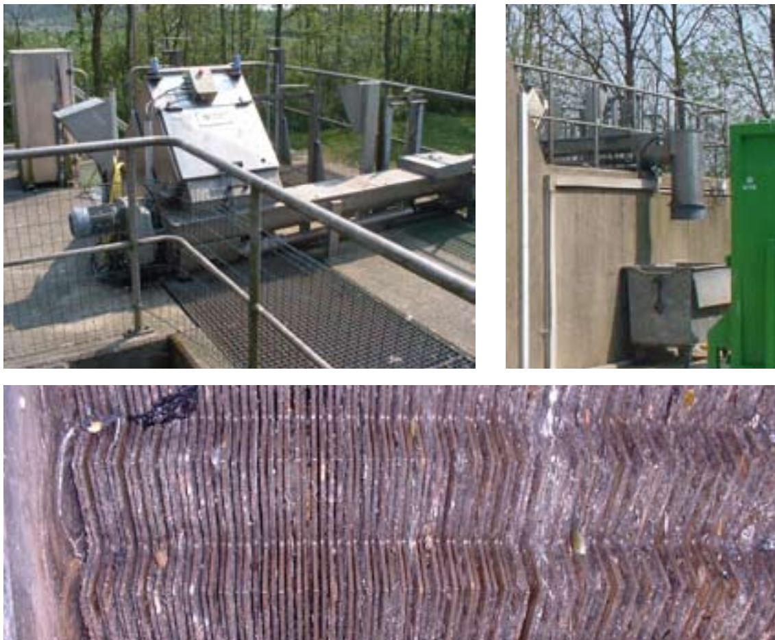
AFBEELDING 28 ROOSTERGOEDVERWIJDERING OP RWZI OUDE TONGE
