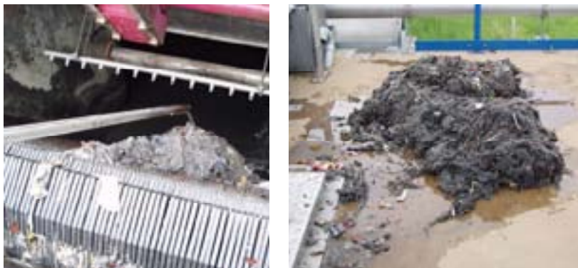
AFBEELDING 35 VOORBEELD VAN 'WORSTEN' OP RWZI HELLEVOETSLUIS
