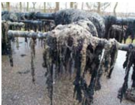
Vervuilde beluchtingselementen op rwzi Beemster
