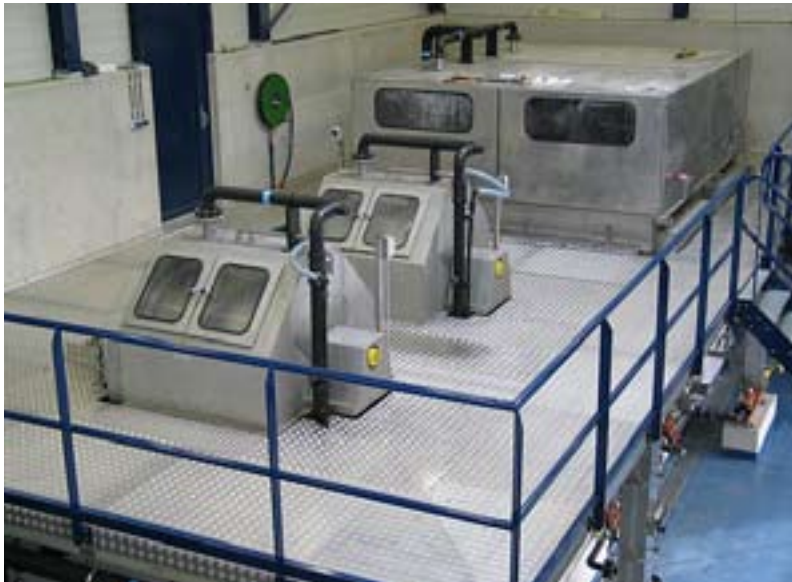
c. trommelzeven (vooraan) en stationaire microzeven (achteraan)
