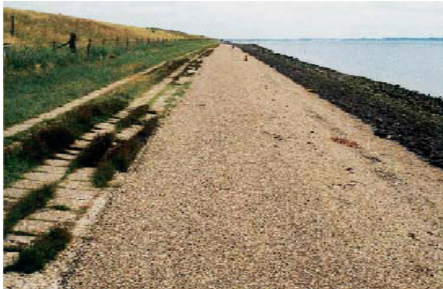
ZEEDIJK MET EEN BEKLEDING VAN WATERBOUWASFALTBETON - OUWERKER - 1996
