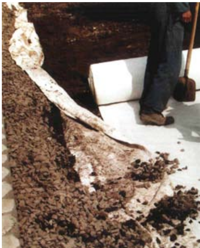
GEOKUNSTSTOF OP DE ROL TIJDENS AANBRENGEN
