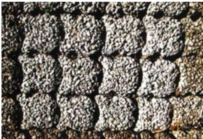
FIGUUR 4.15 GEKANTELTE BETONBLOKKEN
