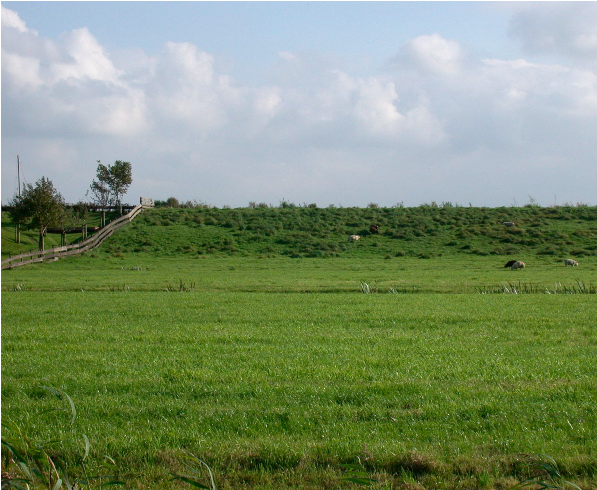
figuur 4 De Drechkade nabij Leimuiden naar het zuiden gezien. De polder op de voorgrond ligt tussen de Haarlemmermeerpolder en de Grootte Heilige-Geestpolder. De kade ligt op zo'n -0,2 m NAP, het maaiveld van de polder op -4,3 m. (© Swartvast – Rens Swart)
