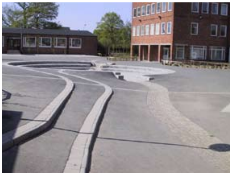
AMFITHEATER OP SCHOOLPLEIN IN MALMÖ DAT OOK DIENT VOOR DE BERGING VAN REGENWATER
