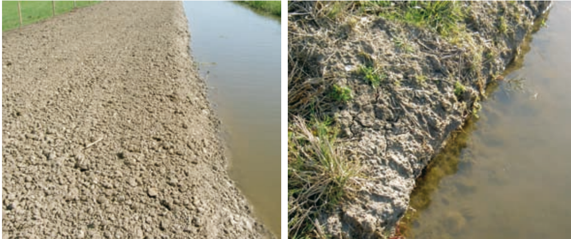
SITUATIE SEPTEMBER 2004, KORT NA AANLEG
