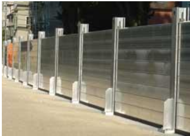
FIGUUR 1.1 TYPEN MOBIELE KERINGEN. LINKS: MODERN SCHOTBALKSYSTEEM. MIDDEN: OUD SCHOTBALKSYSTEEM (PLANKEN MET PAARDENMEST). RECHTS: TIJDELIJKE KERING
