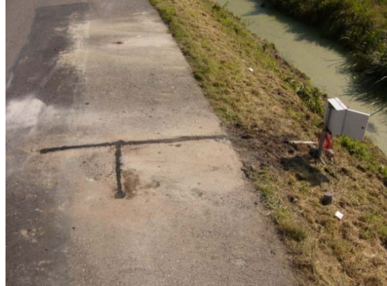
Resultaat na plaatsing waterspanningsmeters
