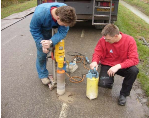
Asfaltboring voor plaatsen waterspanningsmeter
