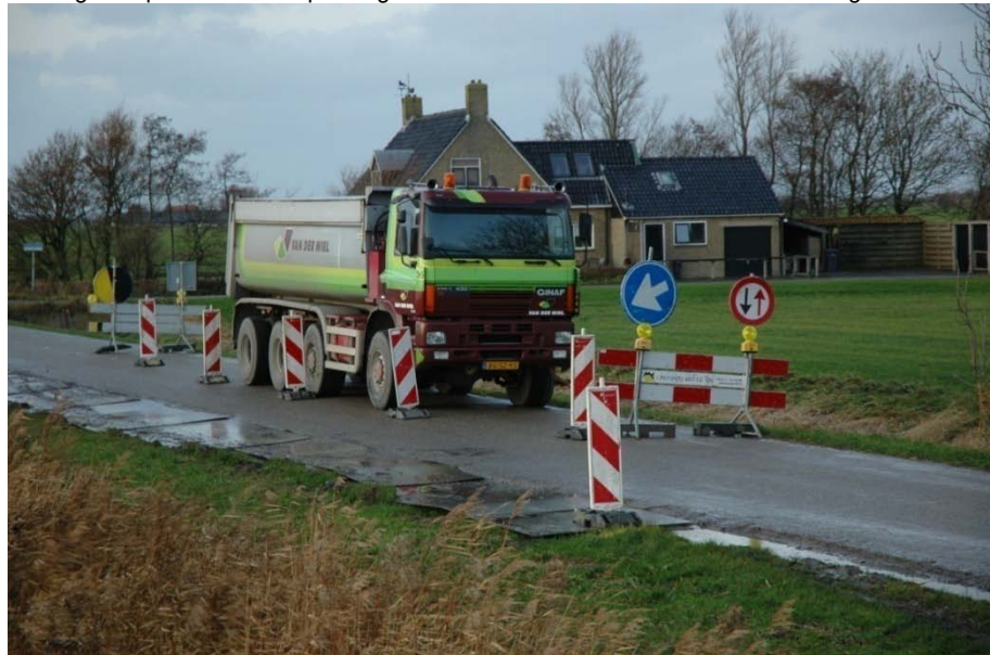
Zandwagen met verkeersmaatregelen en rijplaten belast statisch gedurende een weekend
