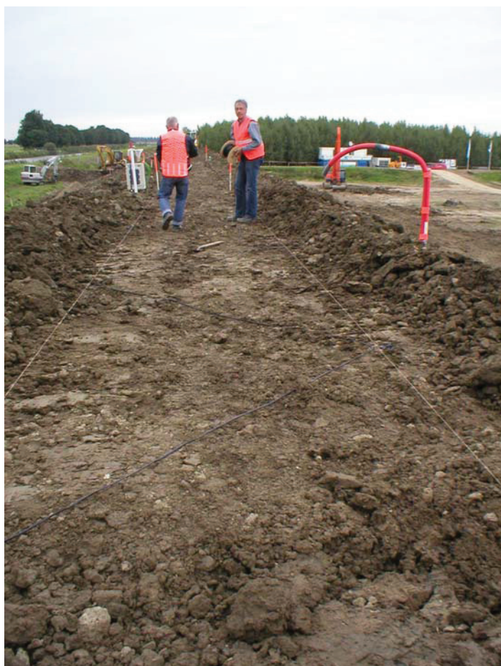
Figuur 5 Handmatige installatie van de detectiekabels 21 t/m 23 in de kruin van de dijk
