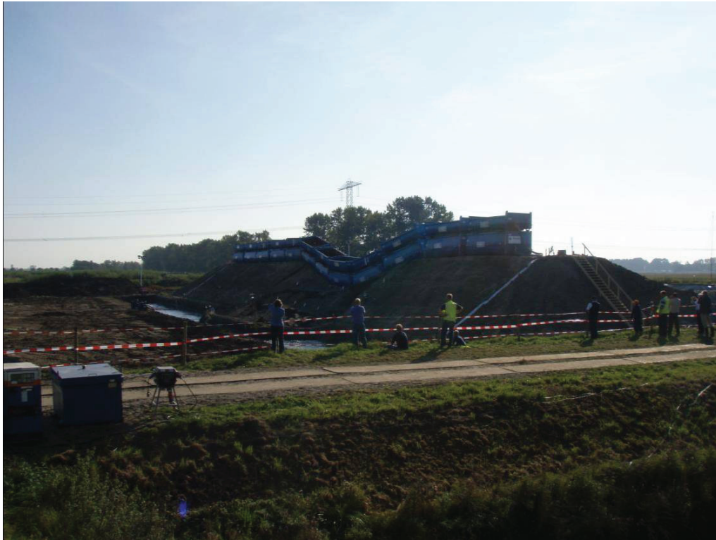
Figuur 4.12 Proefdijk na afschuiving.
