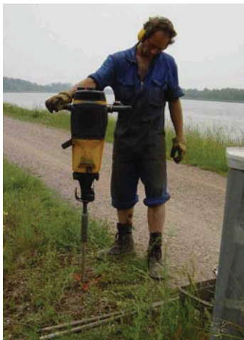
Afbeelding 7 Heien van de meetbuizen (voorbeeldfoto)
