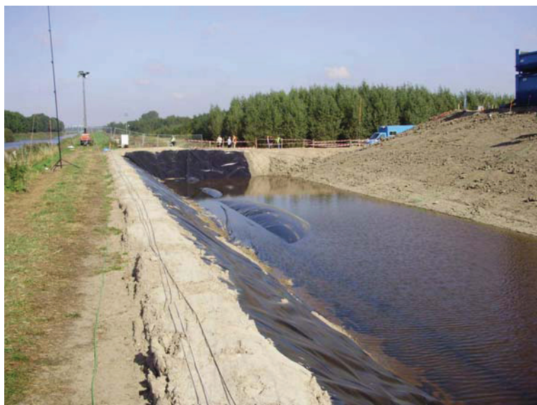
Figuur 4.8 Vullen van het bassin aan de buitenzijde van de proefdijk.
