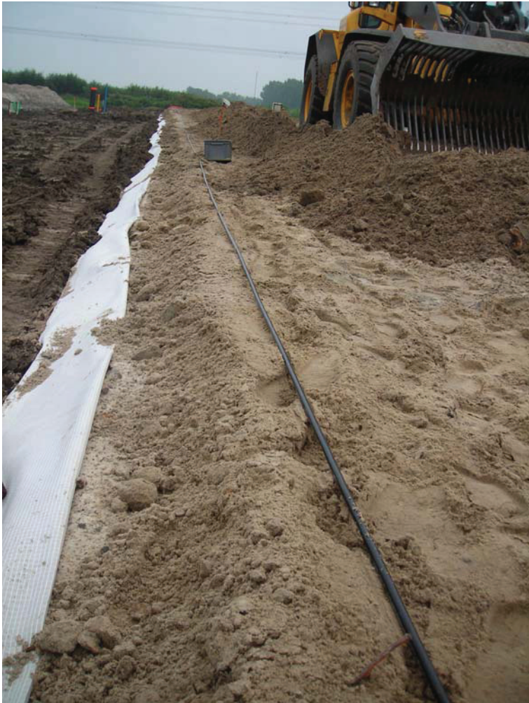
Afbeelding 3 Vezeloptisch kabel gedurende het leggen. Het kabel werd in de zandkern (rechts in beeld) bij de overgang naar de kleilaag aan het dijktalud (links van het geotextiel) gelegd.
