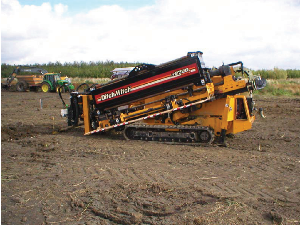
Figuur 3 Boorinstallatie voor het inbrengen van de detectiekabels 11 t/m 13
