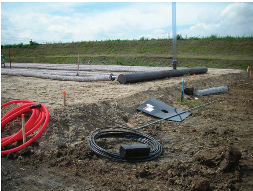
Afbeelding 1 Laagste positie van het vezeloptische kabel in de dijk.
