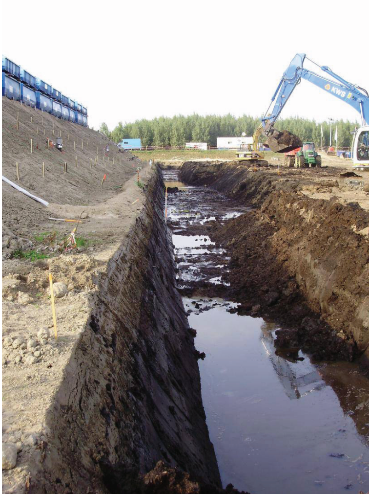
Figuur 4.10 Ontgraving tot aan de zandlaag.
