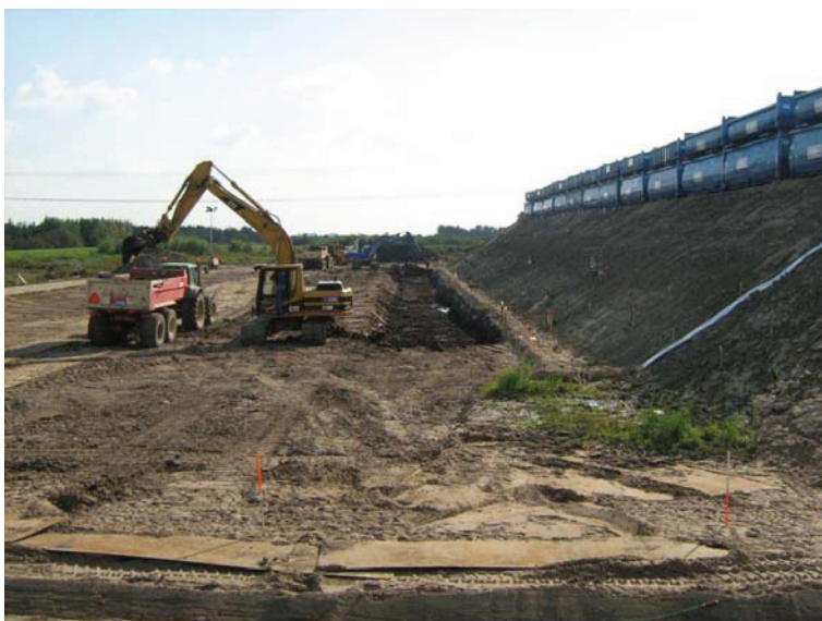
Figuur 4.9 Ondiepe ontgraving
