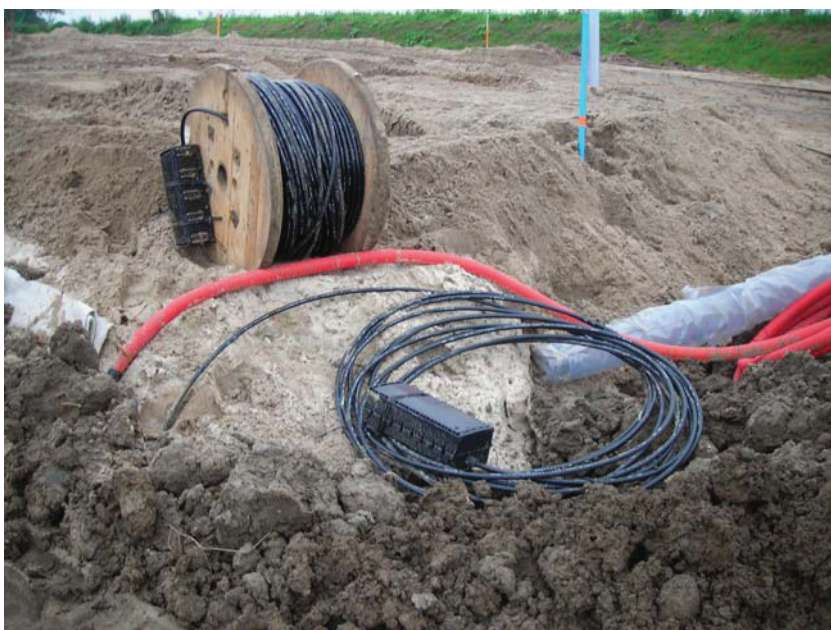
Afbeelding 2 Vezeloptische kabel gedurende het leggen. Een einde van het kabel is samen met de kabelmof op de kabeltrommel gerold, aan het andere gereeds gelegde kabeleinde is ook een kabelmof gemonteerd
