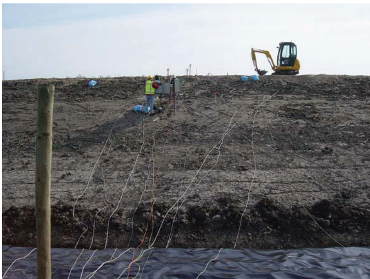
Afbeelding 8 Verloop van de meetleidingen over het waterbassin naar de kanaaldijk.
