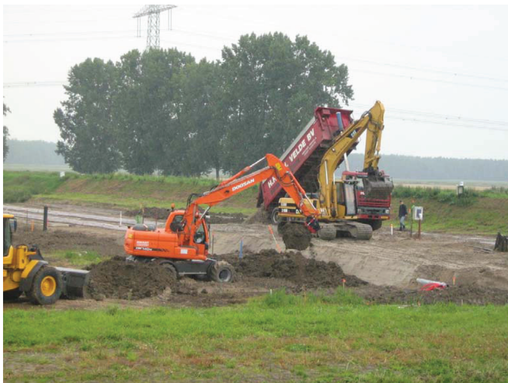
Figuur 3.4 Aanleg van de stabiliteitsdijk, halverwege augustus 2008
