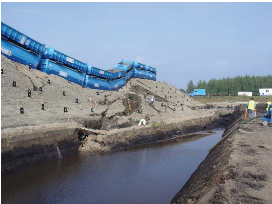
De doorgebroken IJkdijk
