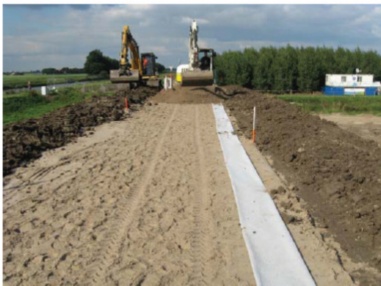
Figuur 5.10.5 Installatie van de derde Geodetect-strip op de zandkern, onder de kruin van de dijk.
