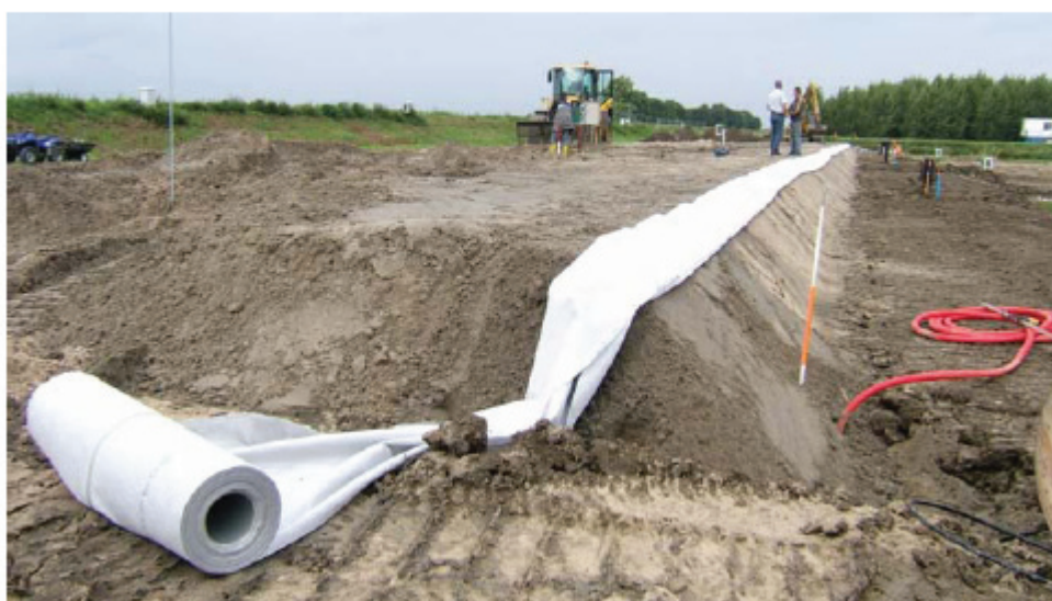
Figuur 5.10.4 Installatie van de tweede Geodetect-strip langs het binnentalud van de dijk.
