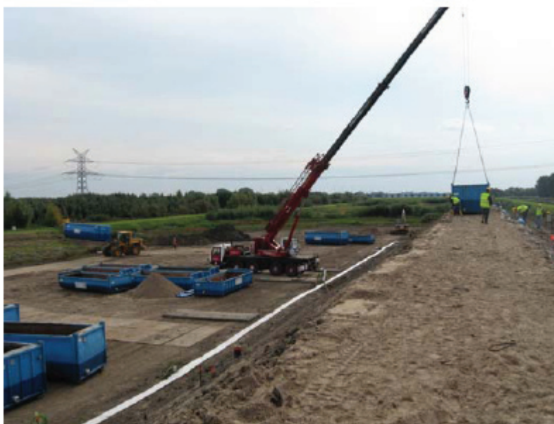
Figuur 5.10.6 Installatie van de vierde Geodetect-strip op de berm, aan de rand van de tijdens de proef te graven sloot (onderaan de dijk).
