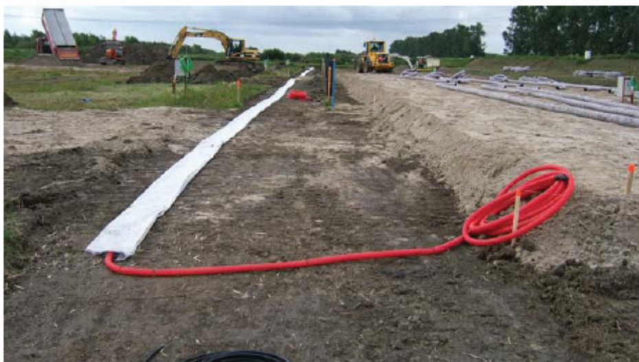
Figuur 5.10.3 Installatie van de eerste Geodetect-strip in de teen van de dijk.
