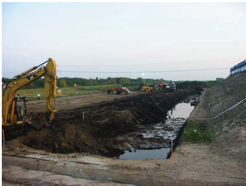
Figuur 11 Diepe ontgraving van de greppel aan de voet van de dijk.
