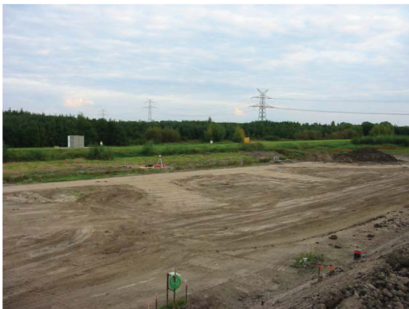
Figuur 4 Opstelling terrestrische laserscanner. De opstelling stond op een afstand van 47 meter t.o.v. het centrum van de dijk.
