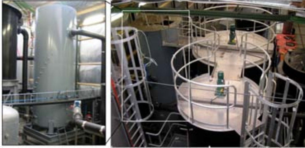
AFBEELDING 13 VLOKVORMINGSTANK (ZWART OP VOORGROND) EN VASTBEDFILTER (LINKS IN DETAIL) IN STRAAT B
