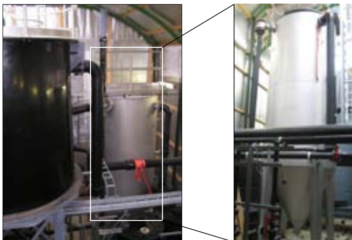
AFBEELDING 11 VLOKVORMINGSTANK (ZWART OP VOORGROND) EN CONTINU ZANDFILTER (RECHTS IN DETAIL) IN ONDERZOEKSSTRAAT A
