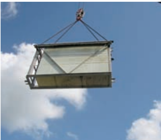
MEMBRAANMODULE MET 180 MEMBRAANPLATEN
