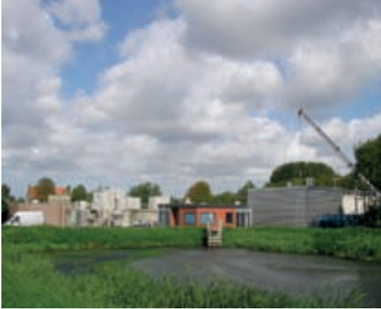
SLIBLAGUNE, BEDRIJFSGEBOUW EN TECHNISCHE RUIMTE
