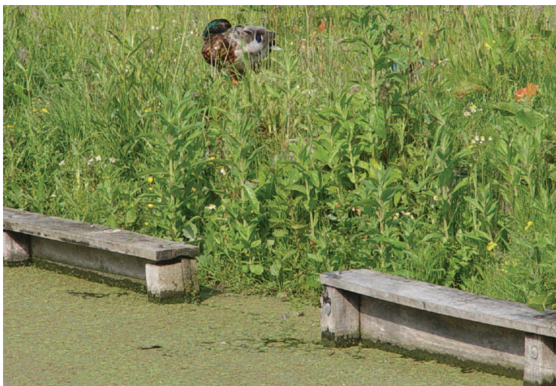
Fig 5.2 VOORBEELD VAN BESCHOEIING INCLUSIEF EEN IN- EN UISTAPPLAATS VOOR FAUNA
