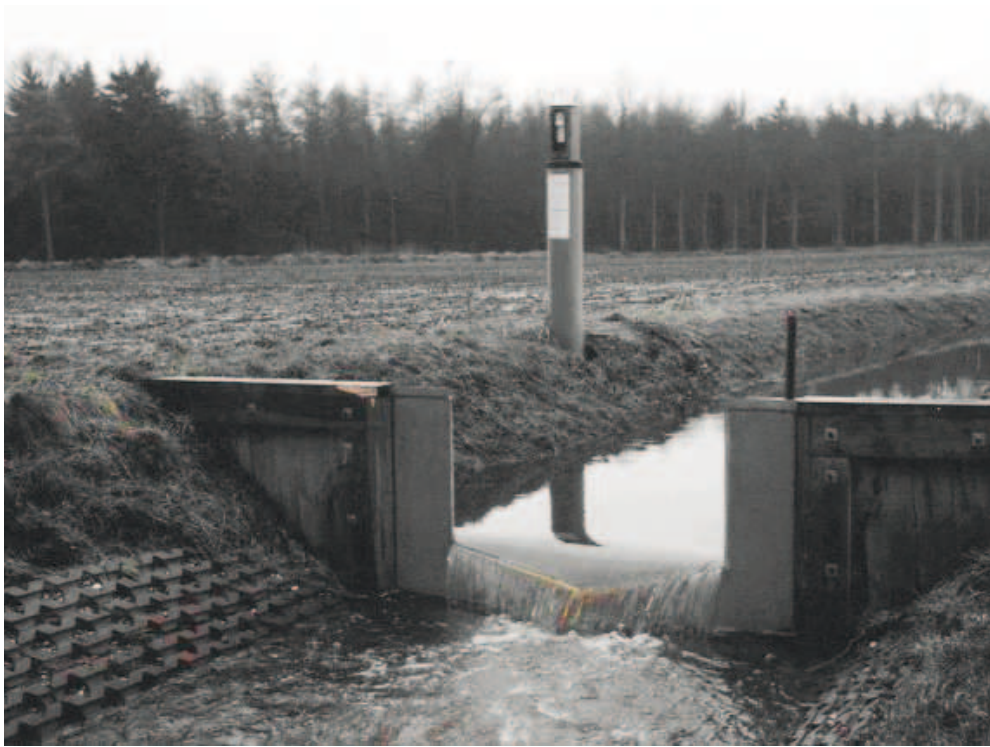
V-VORMIGE OVERLAAT IN DE BOVEN-REGGE BIJ DIEPENHEIM (FOTO: WS REGGE EN DINKEL)
