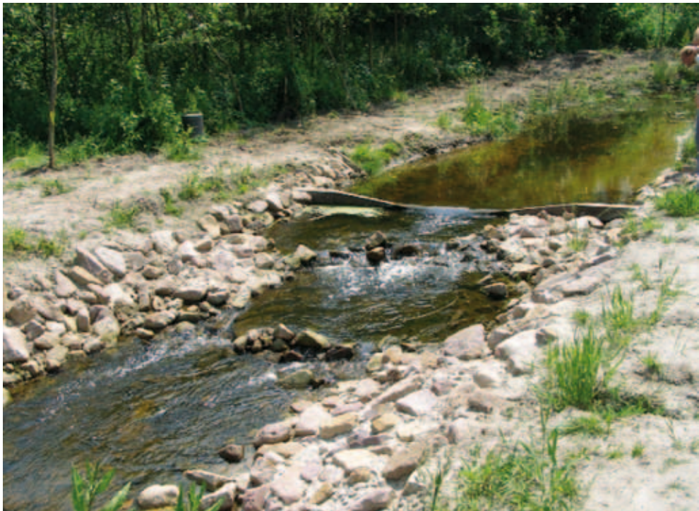
V-VORMIGE OVERLAAT IN DE BOVEN-REGGE BIJ DIEPENHEIM (FOTO: WS REGGE EN DINKEL)
