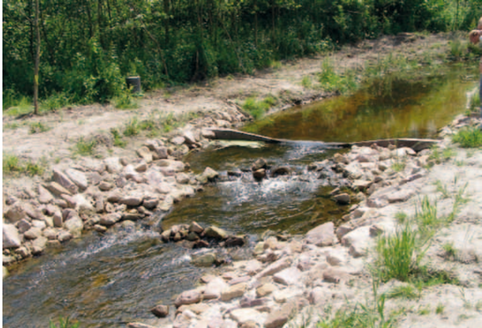
VISPASSEERBARE V-VORMIGE OVERLAAT (FOTO: WS REGGE EN DINKEL)
