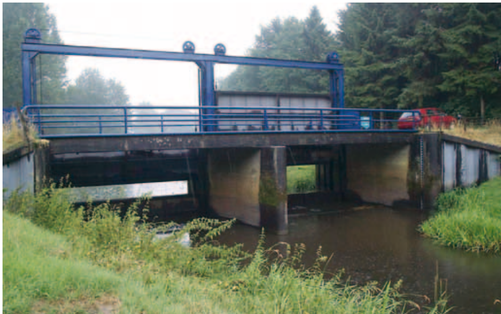
FOTO 6-2 SEGMENTSTUW GROENE KANAAL (FOTO: WS RIJN EN IJSSEL)
