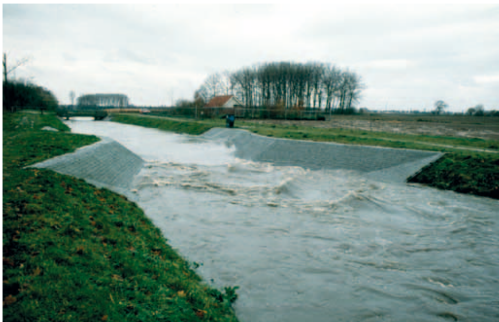
TRAPEZIUMVORMIGE MEETGOOT IN DE GELEENBEEK BIJ MUNSTERGELEEN (FOTO: WS ROER EN OVERMAAS)
