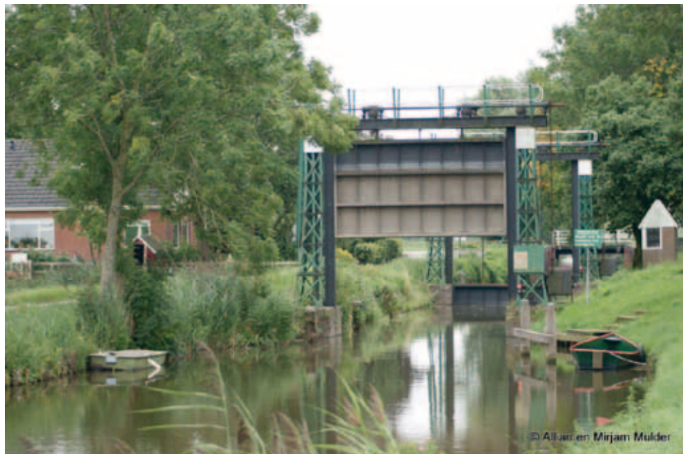
CONESCHUIF OOSTERDIJKSHORNERVERLAAT (FOTO: WS NOORDERZIJLVEST)
