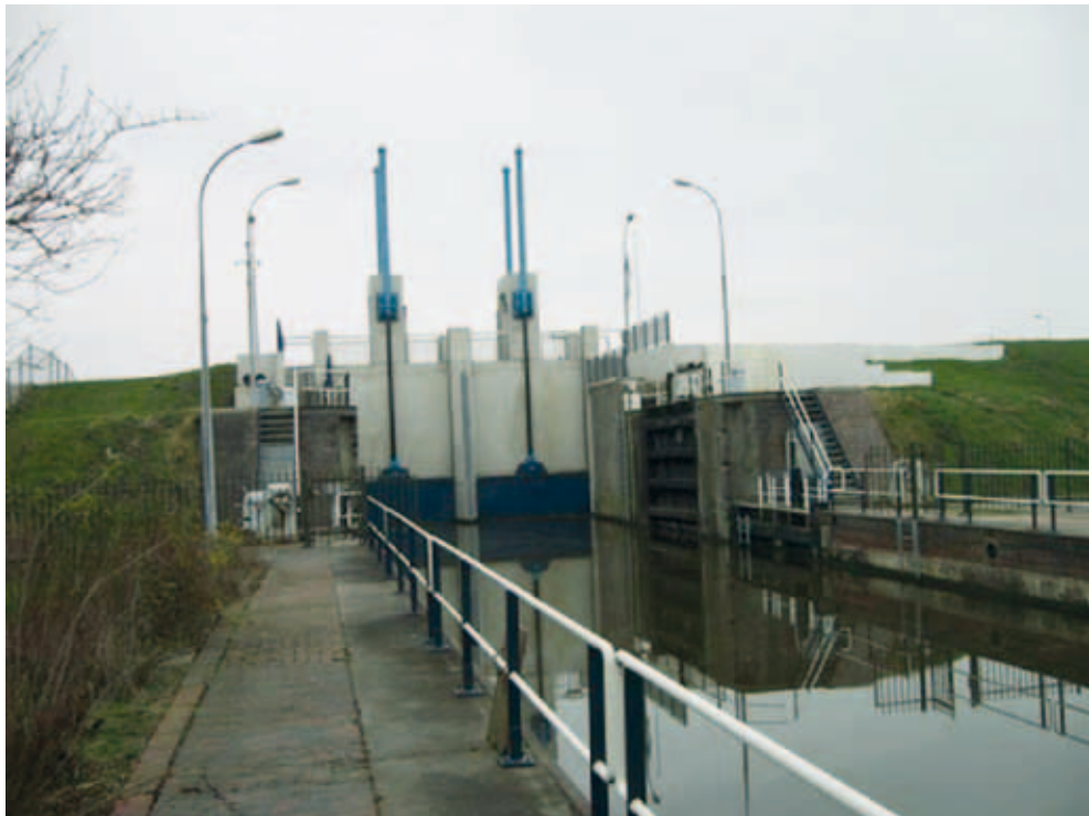
SPUISLUIS DELFZIJL, WS HUNZE EN AA'S (FOTO: HKV LIJN IN WATER)
