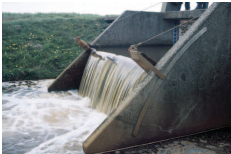
KLEPSTAND AANWIJZING OP DE BETONRAND (FOTO: WAGENINGEN UNIVERSITEIT)
