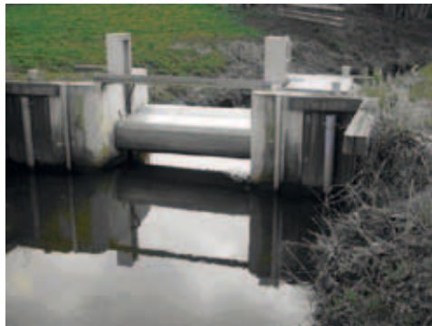
VENTURI-MEETDOORLAAT IN DE STRIJBEKSE BEEK (FOTO: WS BRABANTSE DELTA)
