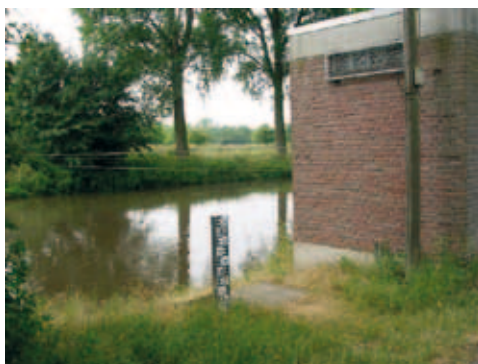
STAH (D) IN DE ROER, AFVOERMEETSTATION MET KABELBAAN
