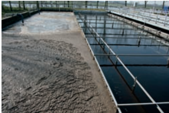
DE TWEE RECIRCULATIESTROMEN VANUIT USBF IN DE DENITRIFICATIE-TANK
