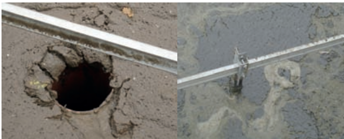
FIGUUR 16 LINKS: TE LAGE WATERSTAND VOOR GOEDE AFVOER DRIJFLAAG, RECHTS TE HOGE WATERSTAND
