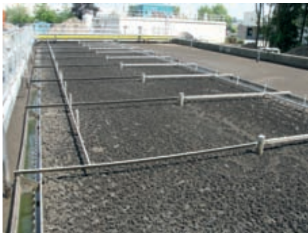
FIGUUR 15 DRIJFLAAGVORMING OP COMBI-USBF, MET DUIKSCHOTTEN (30 OKT. 2006)
