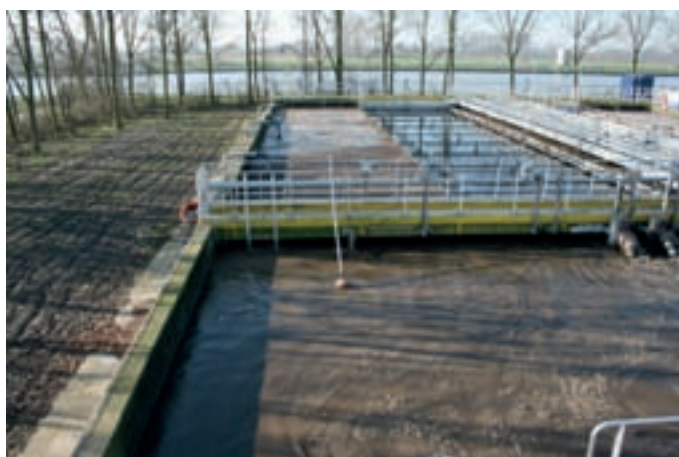
FIGUUR 17 SCHOON WATEROPPERVLAK COMBI-USBF (MAART 2007)
