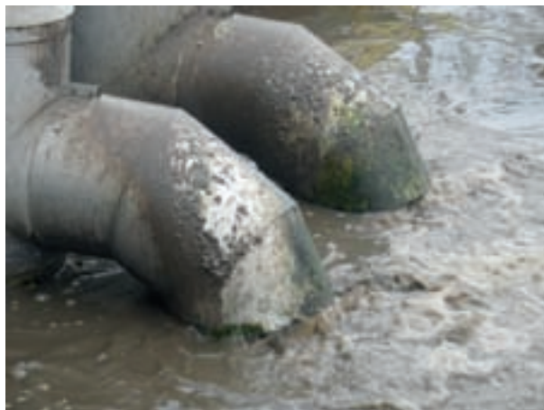
DE TWEE RECIRCULATIESTROMEN VANUIT USBF IN DE DENITRIFICATIE-TANK
