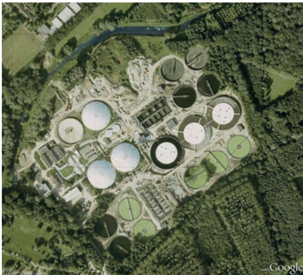
AFBEELDING 4.1 RWZI EINDHOVEN, GROOTSTE VAN DE 13 GESELECTEERDE ZUIVERINGEN
