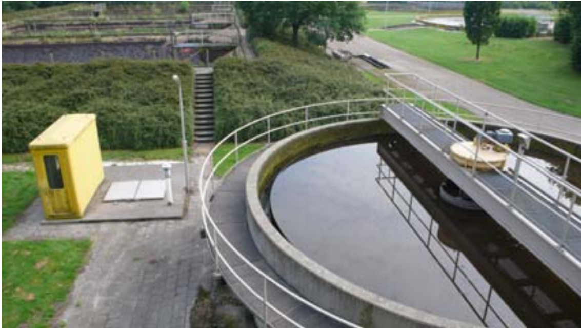
FOTO 2 GEDEELTELIJK GEVULDE SLIBBUFFER MET DECANTEER- EN MENGVOORZIENING
