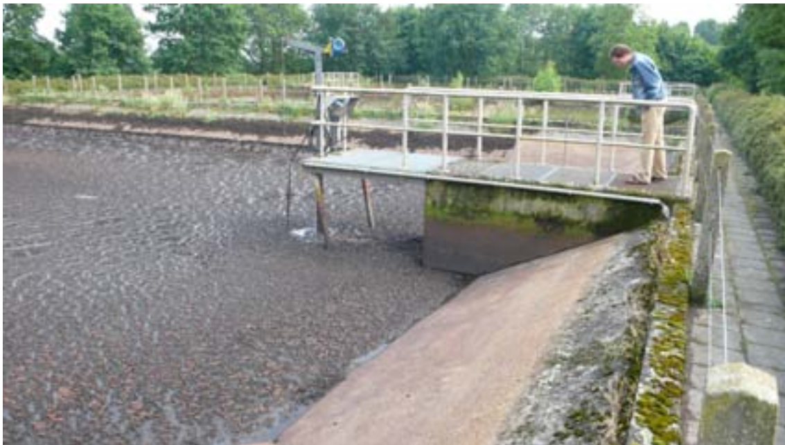
FOTO 2 GEDEELTELIJK GEVULDE SLIBBUFFER MET DECANTEER- EN MENGVOORZIENING
