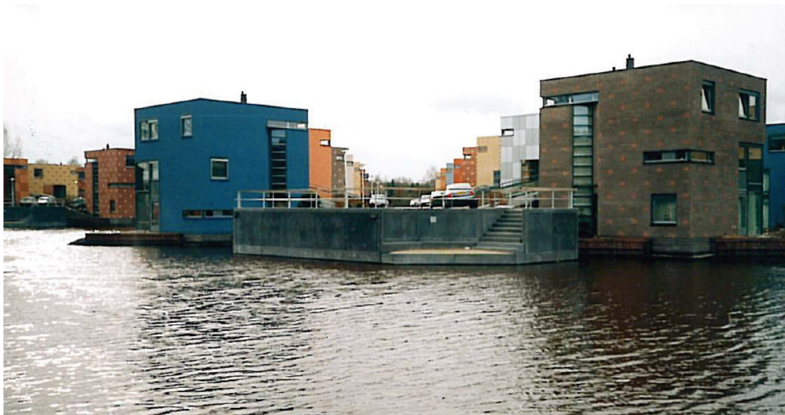
BOUWEN AAN HET WATER (BRON: WATERSCHAP REGGE EN DINKEL)
