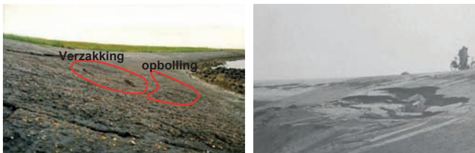
VOORBEELDEN VAN INSTABILITEIT VAN ONDERGROND
