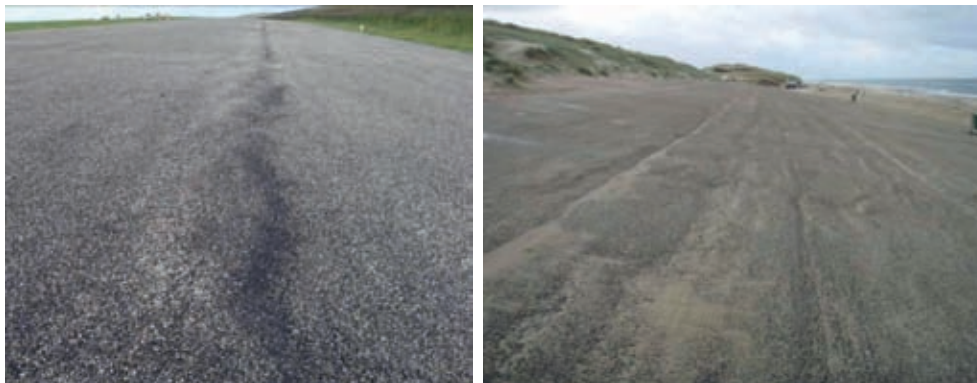
ENKELE STROOKVORMIGE OPBOLLINGEN
