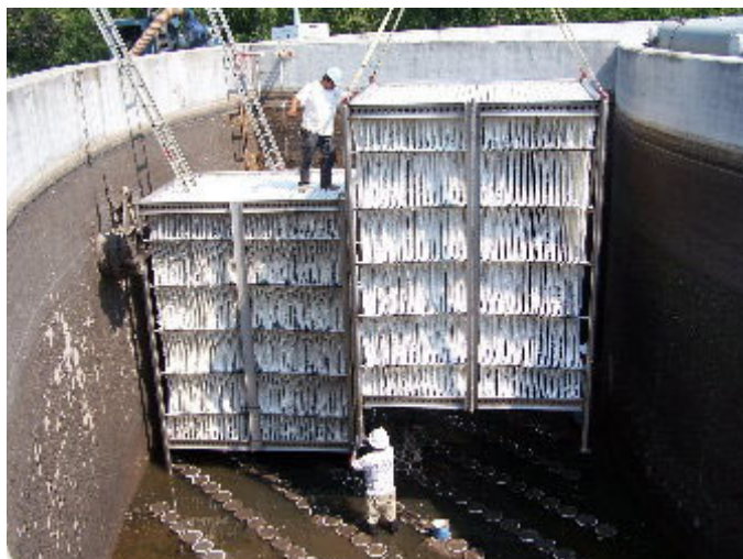
INSTALLATIE VAN BIOWEB DRAGER (GEMONTEERD OP RVS FRAMES)
