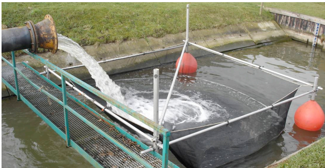
figuur 3.4 Netconstructie voor opvang van de uitgemalen vissen
