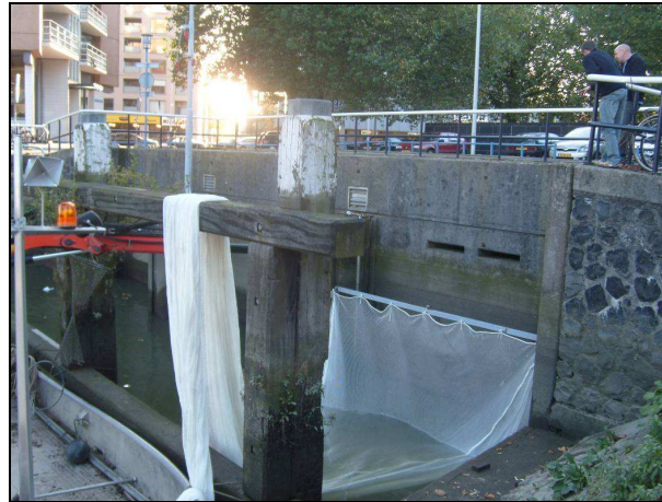
figuur 2.2 Plaatsing van het passagenet bij opvoerwerk Schilthuis
