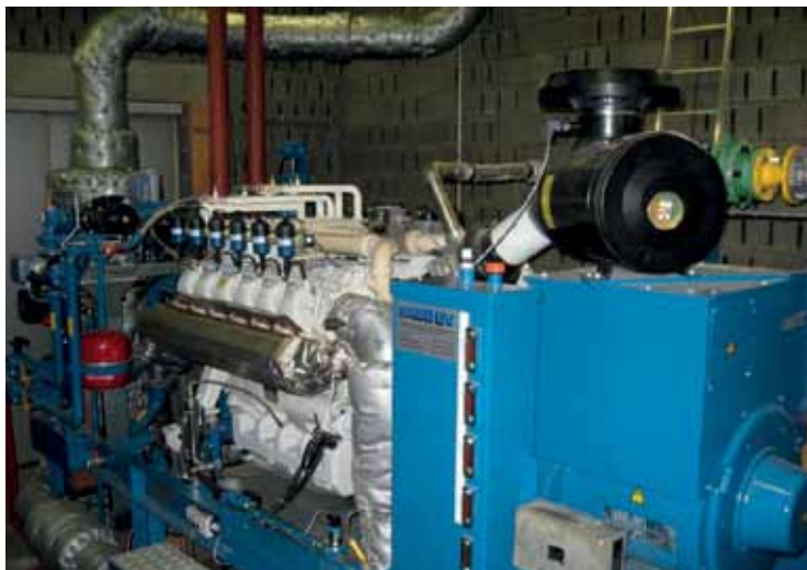
FIGUUR 2-3 BINNENOPSTELLING VAN WKK OP RWZI DEN BOSCH (IN AANBOUW)
