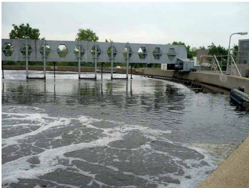
BELUCHTINGSTANK RWZI DRUTEN (FOTO: D.N. DE HEER)
