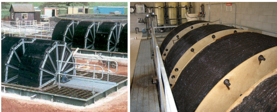
AFBEELDING 6 VOORBEELDEN VAN ROTERENDE BIOLOGISCHE SYSTEMEN BIJ EEN WATERZUIVERINGSINSTALLATIE MET ACTIEFLIB
