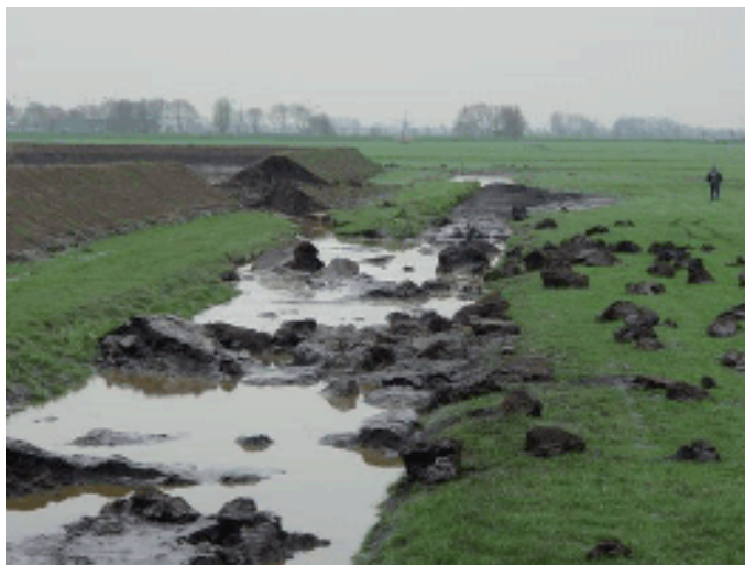
FIGUUR 51 AFSCHUIVEN VAN EEN KADE ALS RISICOFACOR BIJ EEN BAGGERDEPOT (FOTO GEMEENTE KAAG EN BRAASSEM).
