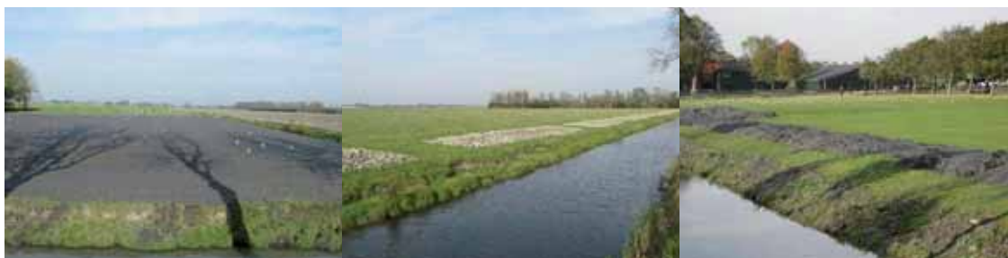
FIGUUR 5 VOORBEELDEN VAN VERSCHILLENDE MANIEREN VAN VERSPREIDEN VAN BAGGER: VERSPREID OVER PERCEEL OF ALS EEN SMALLE STROOK NAAST DE WATERGANG.
