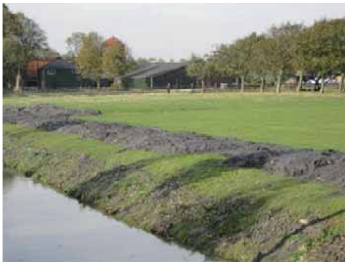
VERSPREIDEN VAN BAGGER OP EEN LANDBOUWPERCEEL.
