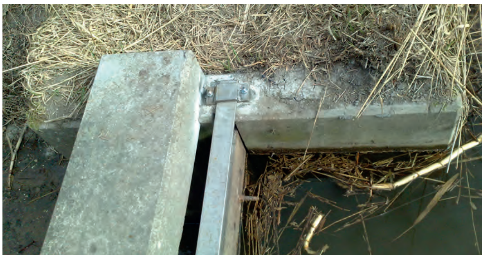
FIGUUR 4.9 BESTAANDE BETONCONSTRUCTIE STUW MET VERGREDELING SCHOTBALKEN
