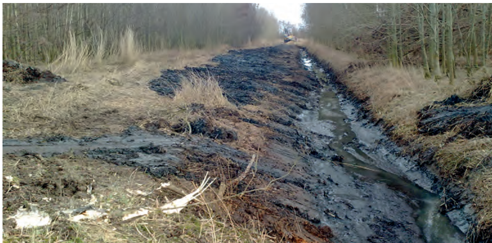
FIGUUR 4.8 OPGESCHOONDE WATERGANG
