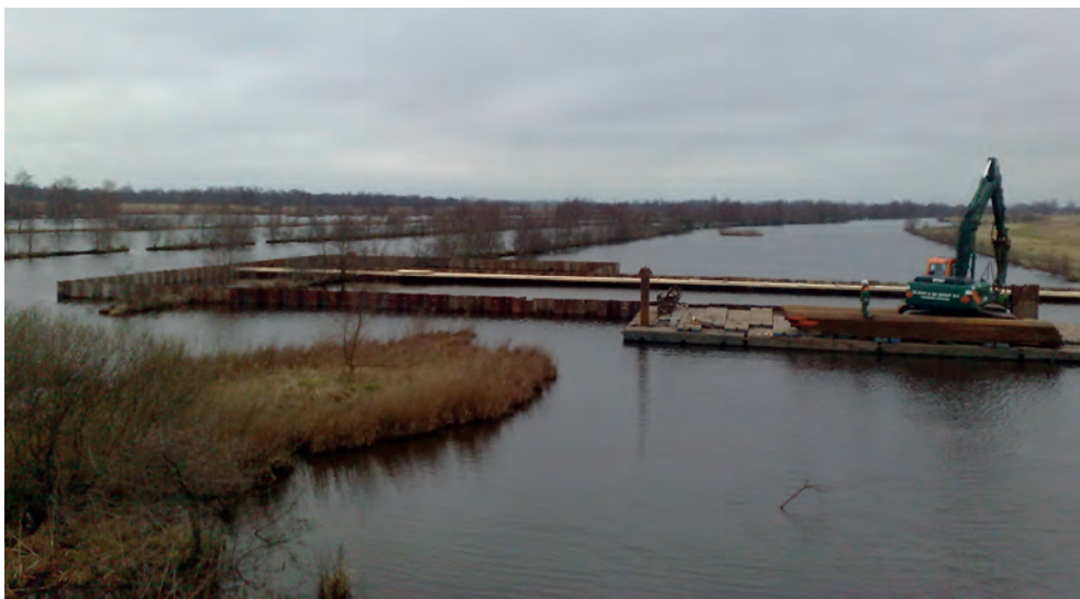
FIGUUR 4.19 AANBRENGEN STALEN DAMWANDEN
