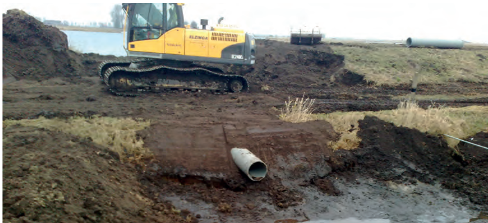
FIGUUR 4.13 NOODOVERLOOP IN DIJKLICHAAM
