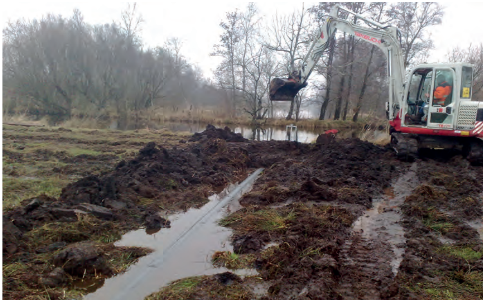
FIGUUR 4.17 AANBRENGEN DUIKER IN BESTAANDE KADE
