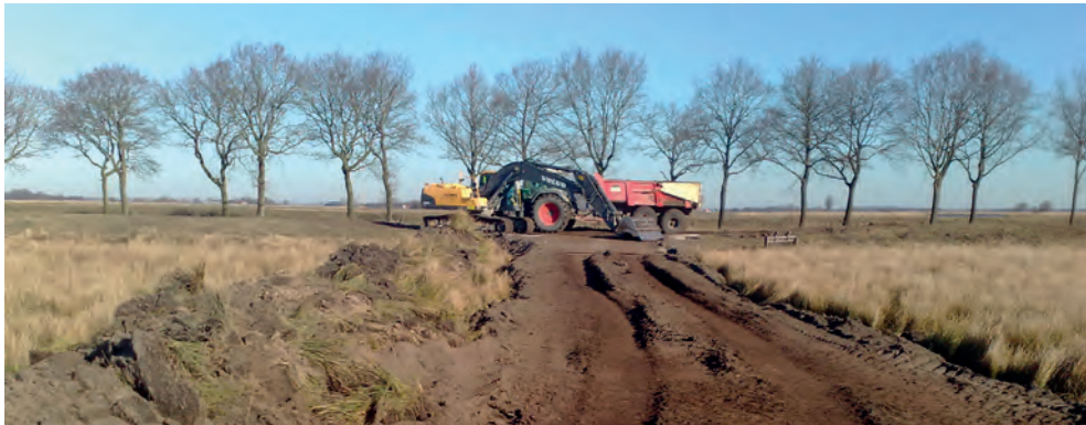
FIGUUR 4.11 PAD TUSSEN GRONDDAM EN DIJK
