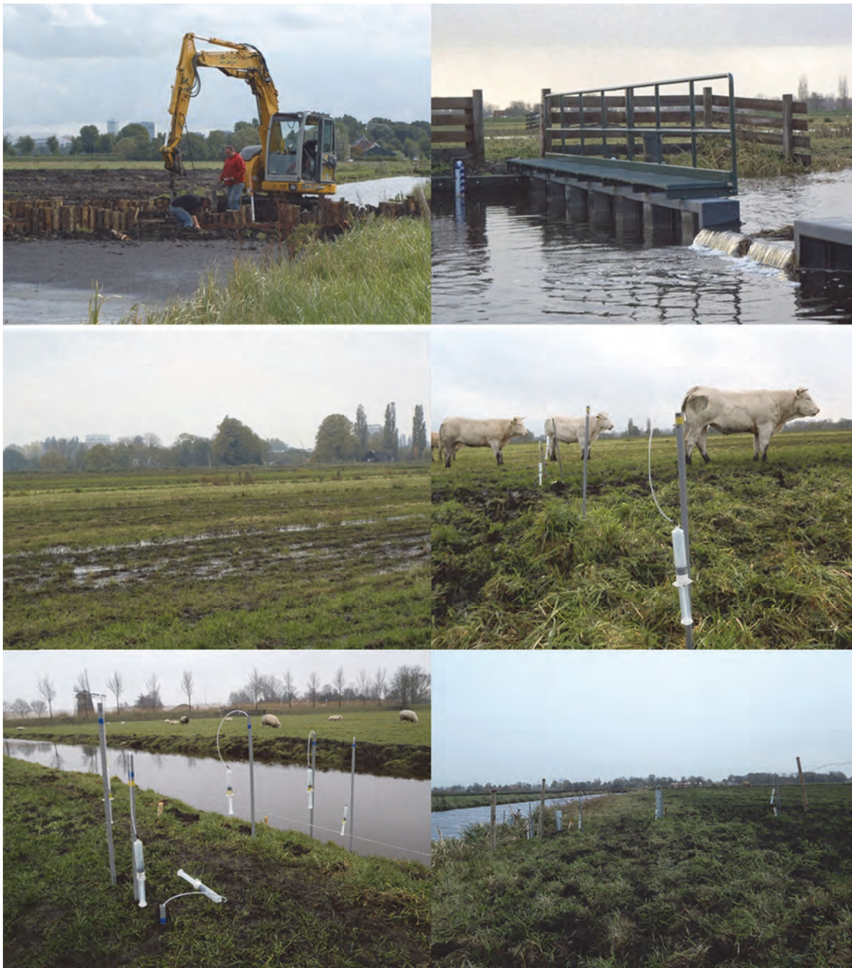
Figuur 4.4.1. Middelpolder. Linksboven, aanleg van een dammetjes die het mogelijk maakt het gebied hydrologische te isoleren. Rechtsboven, stuw t.b.v. inlaat en uitlaat van oppervlaktewater. Midden links, drassige condities langs één van de haarvaten; Midden rechts, begrazing door runderen; Linksonder, bodemwaterraai buiten het flexpeilgebied; Rechtsonder, bodemwaterraai buiten het flexpeilgebied.
