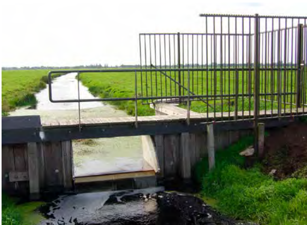
AFBEELDING 2.3.3 UITLATEN VAN WATER MIDDELS EEN HANDMATIGE STUW.
