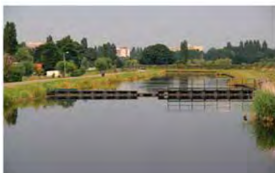
MIDDELPOLDER: DAM TER ISOLATIE VAN HET FLEXPEIL GEBIED (OP DE ACHTERGROND).
