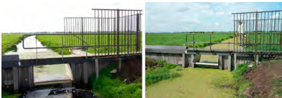
AFBEELDING 8.0.3 STUW IN POLDER RONDEHOEP BIJ EEN HOGE EN LAGE WATERSTAND.
