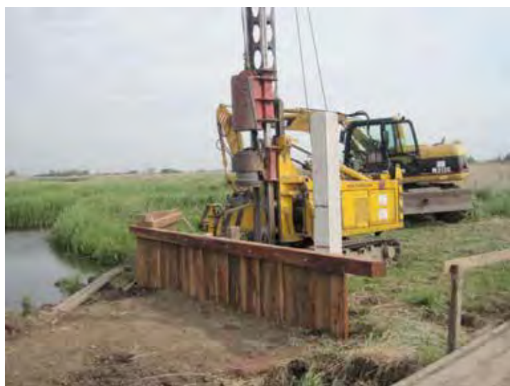
AFBEELDING 7.0.1 PLAATSEN VAN DAMWANDEN. LINKS: TER AFSLUITING VAN HET FLEXPEILVAK IN MIDDELPOLDER. CENTRAAL: TER AFSLUITING VAN VAK 7 IN HET NAARDERMEER. RECHTS: VOOR NIEUWE STUW IN DE NIEUW KEVERDIJKSE POLDER.
