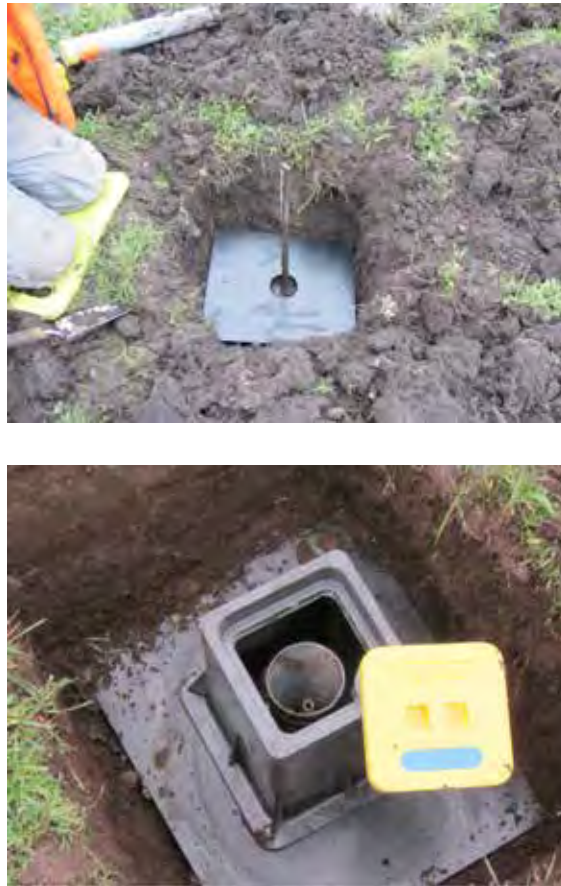
AFBEELDING 5.1.1 VAST MEETPUNT TBV VAN DE MONITORING VAN DE BODEMDALING. BOVEN: FOTO VAN DE STAAF VAN HET VASTE MEETPUNT MET DAAR OMHEEN EEN PLAAT, DIE TER ONDERSTEUNING VAN DE STRAATPOT DIENT. ONDER: DEFINITIEVE AFWERKING VAN HET VASTE MEETPUNT: STAAF AFGEKNIPT TOT ONDER HET MAAIVELD, AFGESCHERMD MET EEN BUIS EN AFGEWERKT MET EEN STRAATPOT.
