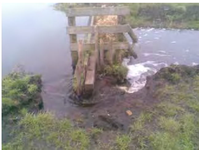
AFBEELDING 7.0.2 PLAATSEN VAN PEILSCHAAL OM DE STUWSTAND NAUWKEURIG AF TE KUNNEN LEZEN (BOVEN). ACHTERLOOPSE STUW IN DE RONDE HOEP VEROORZAAKT DOOR DE HOGE WATERSTAND (ONDER)
