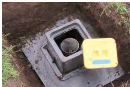
MAAIVELDDALING: EXTENSOMETER TER BESCHERMING AFGEWERKT MET EEN BUIS EN STRAATPOT.
