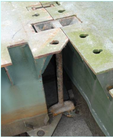
Afbeelding 3-2: Bevestiging van de pontons aan elkaar
