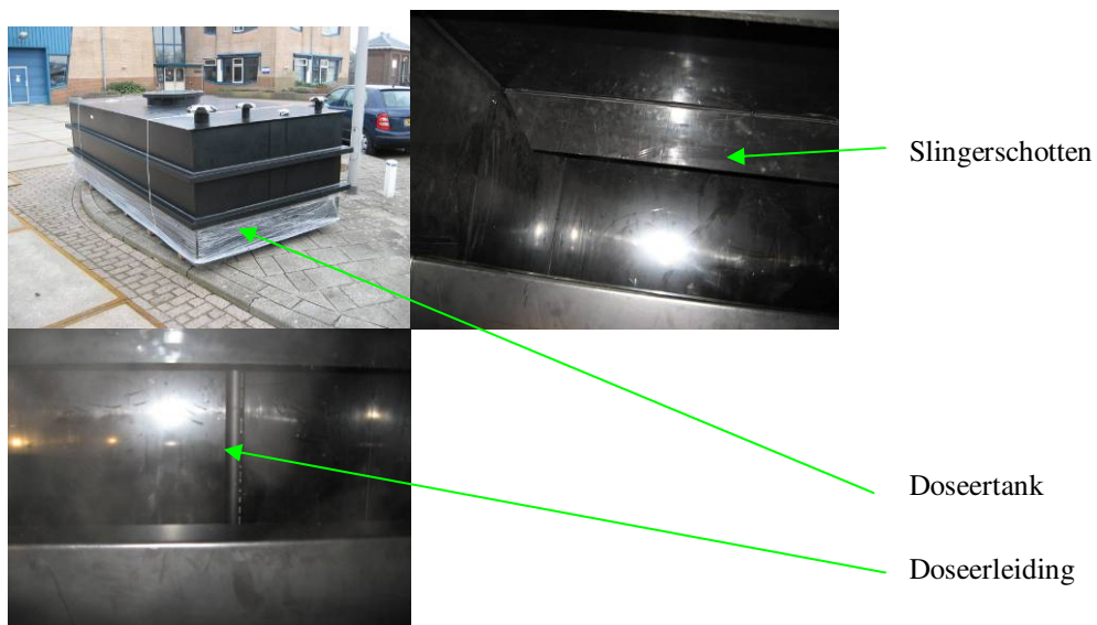
Afbeelding 3-17: Doseertank, slingerschotten en doseerleiding
