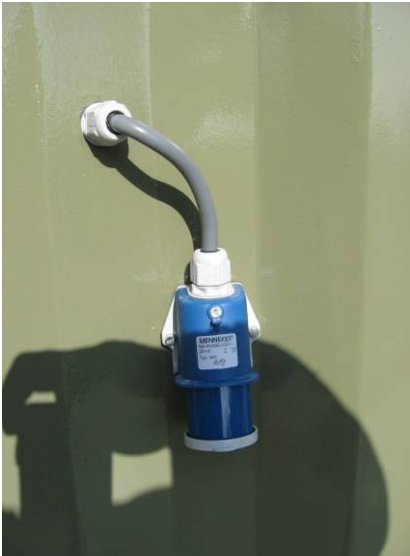
Afbeelding 3-15: Elektra aansluiting voor generator
