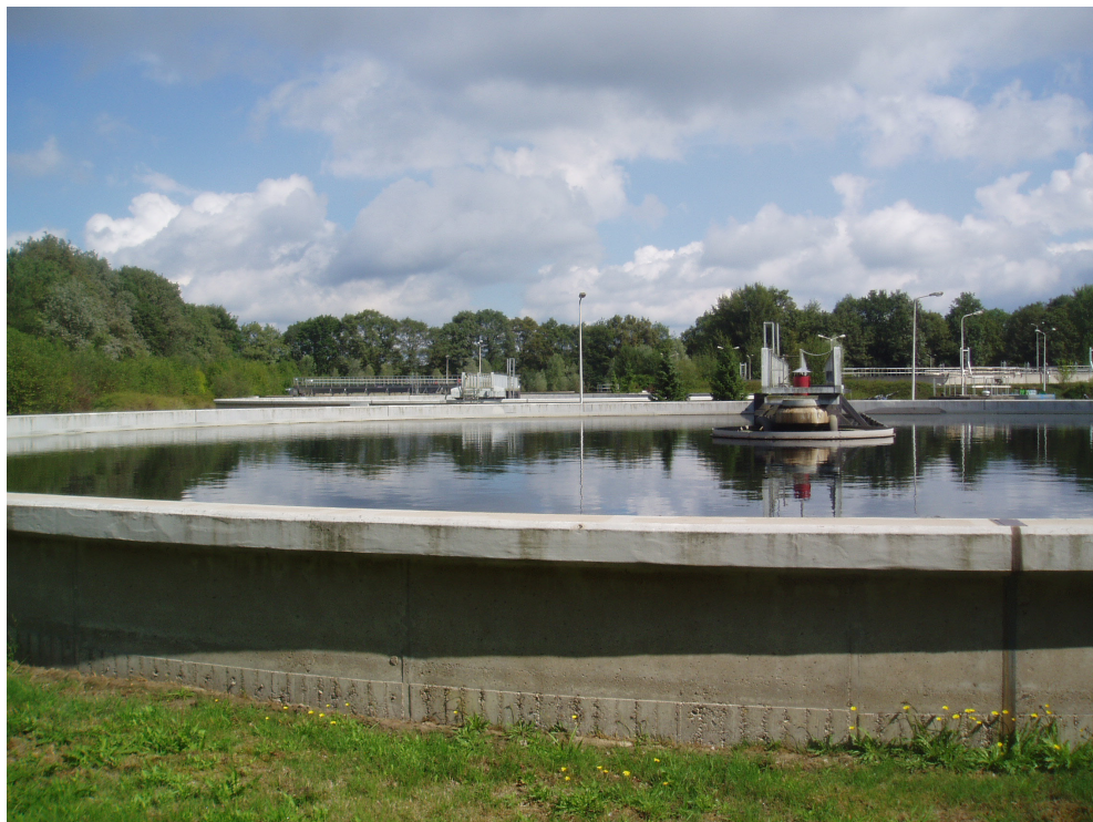
EEN NABEZINKTANK OP DE RWZI OLDENZAAL
