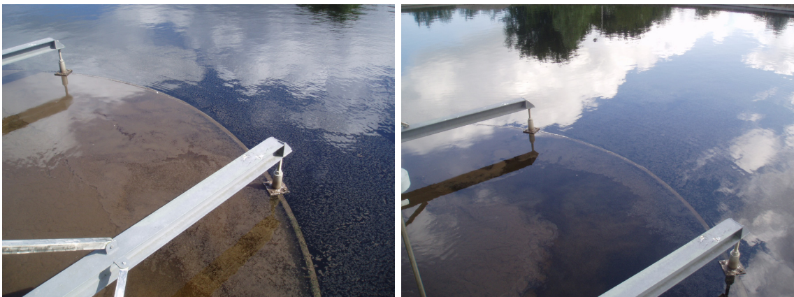
AFBEELDING 13 OPMENING VAN SLIB EN WATER IN DE INLOOPTROMMEL
