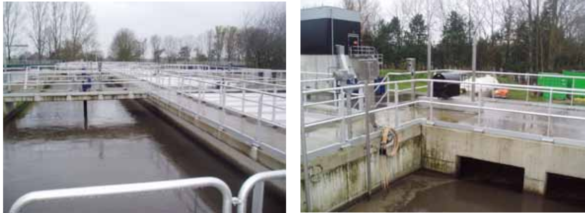
AFBEELDING 17 BUFFERTANKS (LINKS) EN AFSLUITER VAN DE SLIBBUFFER
