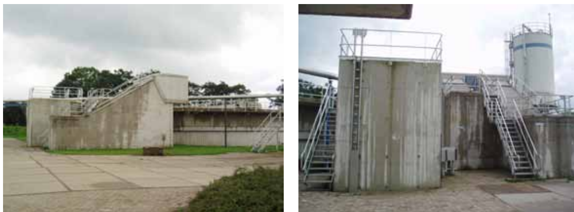
AFBEELDING 24 DE RETOURSLIBPOMPPUT, HET VIJZELGEMAAL EN NABEZINKTANK 3
