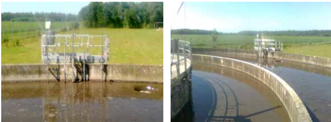
AFBEELDING 10 AFLAATKOKER EN ON-LINE METINGEN OP DE RWZI TER APEL
