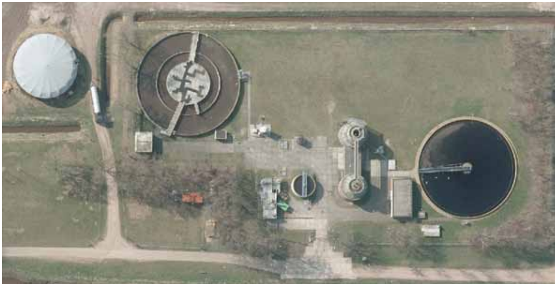
AFBEELDING 4 LUCHTFOTO VAN DE RWZI TER APEL
