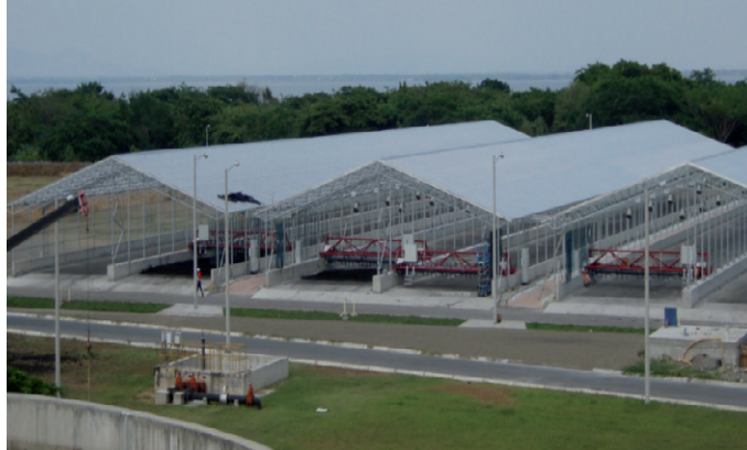
FIGUUR 2.4 KASSEN MET HET WENDEWOLFSYSTEEM MET EEN OPEN VOOR- EN ACHTERKANT
