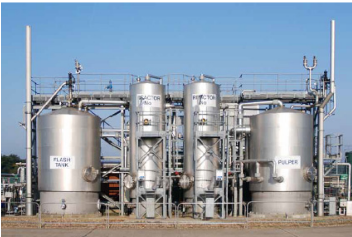
AFBEELDING 1 CAMBI-INSTALLATIE (BIOSOLIDS BROCHURE WWW.CAMBI.COM)
