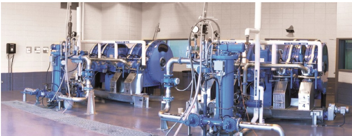
ROTERENDE-SCHIJVENPERS, TWEE MAAL 4 KANALEN (FOURNIER)
