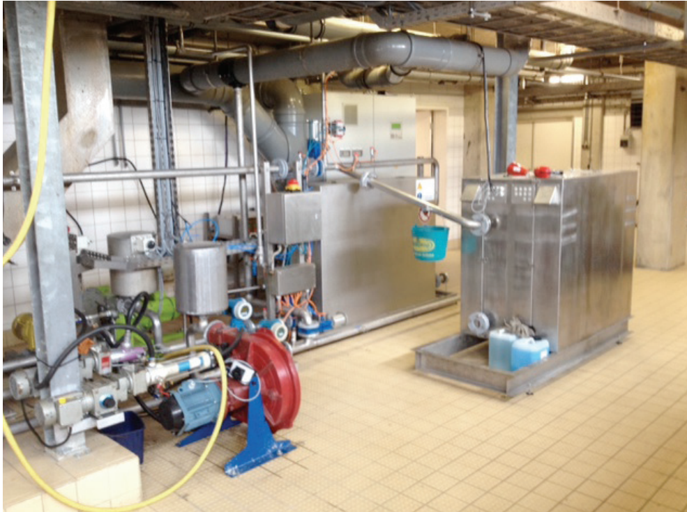
ULTRASONIC INSTALLATIE NIEUWGRAAF
