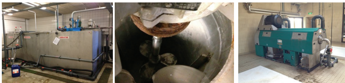
AFBEELDING 13 SLIBONTWATERING HENGelo. LINKS: VOORRAADTANKS STAMOPLOSSING POLYMEER (RECHTS) EN NAVERDUND POLYMEER (LINKS), MIDDEN: ROERDER IN DMU MENGINSTALLATIE, RECHTS: ONTWERINGS-CENTRIFUGE.
