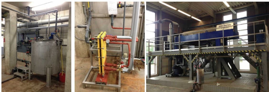
AFBEELDING 9 SLIBONTWATERING DEN BOSCH. LINKS POLYMEERAANMAAK TANK, MIDDEN VOORVERWARMING AANMAAKWATER POLYMEER, RECHTS ONTWATERINGSCENTRIFUGE
