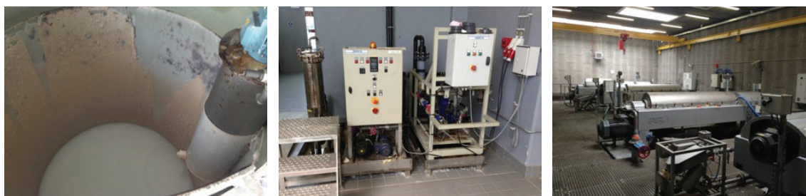
AFBEELDING 11 SLIBONTWATERING AMSTERDAM WEST. LINKS: POLYMEERTANK VOOR SLIBINDIKKERS MET RECHTS DE DMU-UNIT VOOR DE INITIËLE MENGING VAN POLYMEER EN WATER, MIDDEN: TWEE MENG INSTALLATIES VOOR MENGING POLYMEER EN WATER VOOR DE CENTRIFUGES, RECHTS: ONTWATERINGSCENTRIFUGES
