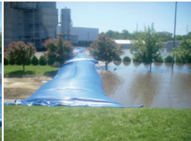
Water-filled dam (photos: Hochwasserschutz Agentur)
