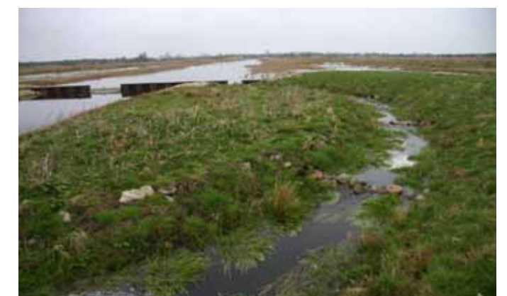
Herstel in uitvoering.
