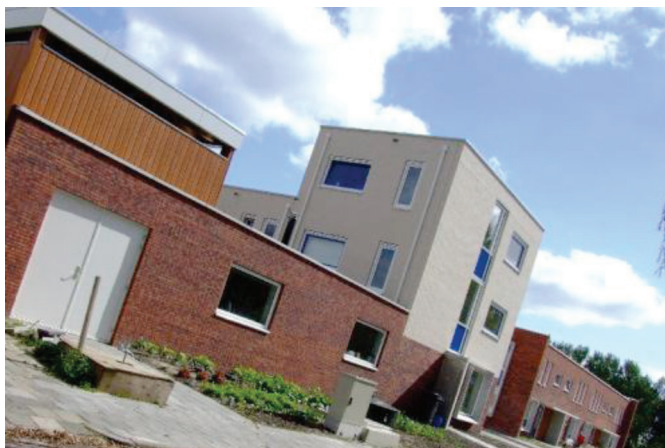
FIGUUR 2.1 DEEL VAN DE WOONWIJK LEMMERWEG-OOST MET DE GARAGE WAARIN HET VERWERKINGSSYSTEEM VOOR GESCHIEDEN RESTSTROMEN IS GEPLAATST
