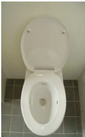
FIGUUR 2.2 VACUÛM TOILET VAN ROEDIGER, TYPE 85 TOEGEPAST IN SNEEK
