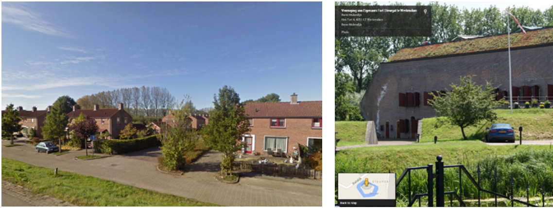
FIGUUR 13 BESTAANDE BEBOUWING (LINKS) EN FORT STEURGAT (RECHTS) TRAJECT 23-1 BIESBOSCH (BRON: GOOGLE)
