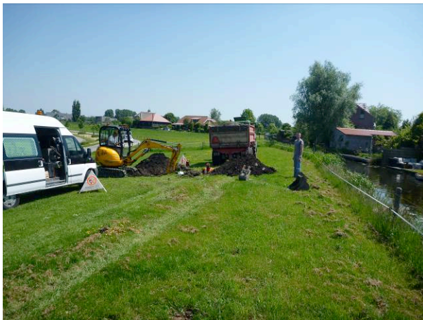
boezemkade Bergsche Linker Rottekade Bergschenhoek, falende waterleiding
