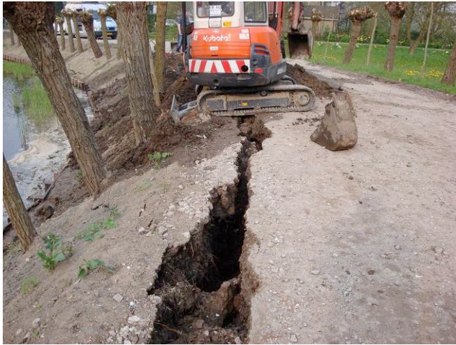
boezemkade Overslingeland Giessenburg, falende waterleiding
