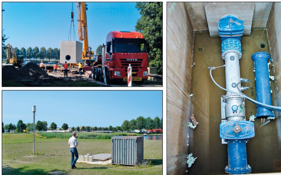
Figuur 3.25 Overzicht meetlocatie Palembangweg (linksonder), installeren nieuwe meetput (linksboven) en zicht in meetput op buis met apparatuur (rechts)
