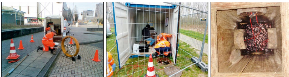
Figuur 3.12 Installeren glasvezelkabel in riool (links), DTS-meetinstrument in container (midden) en glasvezelkabels in riool tijdens metingen (rechts)
