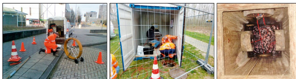
Figuur 9.3 Installeren glasvezelkabel in riool (links), DTS-meetinstrument in container (midden) en glasvezelkabels in riool tijdens metingen (rechts)
