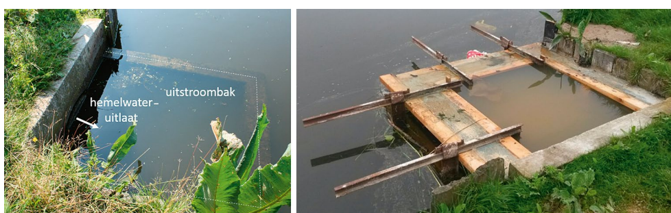
Figuur 6.3 Originele uitstroombak bij locatie Palembang (links) en dezelfde uitstroombak na verhoging rand tot boven oppervlaktewaterniveau op 24 april 2014 (rechts)
