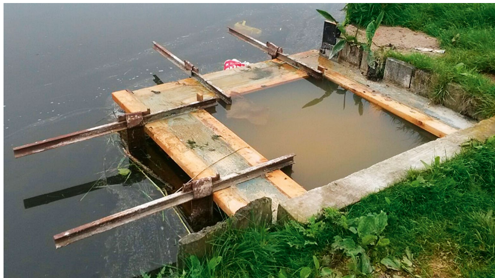
Figuur 4.21 Ophogen rand uitstroombak locatie Palembangweg voorkomt golfindringing uit buitenwater naar meetlocatie
