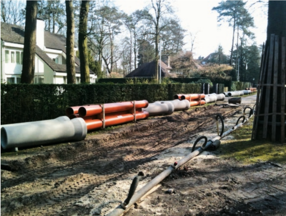
Figuur 1.1 Rioolvervangning in Breda
