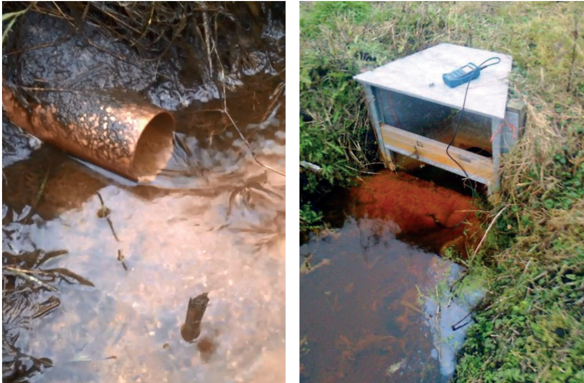
FIGUUR 2.4 DRAIN UISTROOMPUNT (LINKS) EN REGELBARE STUW (RECHTS). BEIDEN MET NEERSLAG VAN IJZEROXIDE-VLOKKEN. BIJ DE STUW OOK EEN
