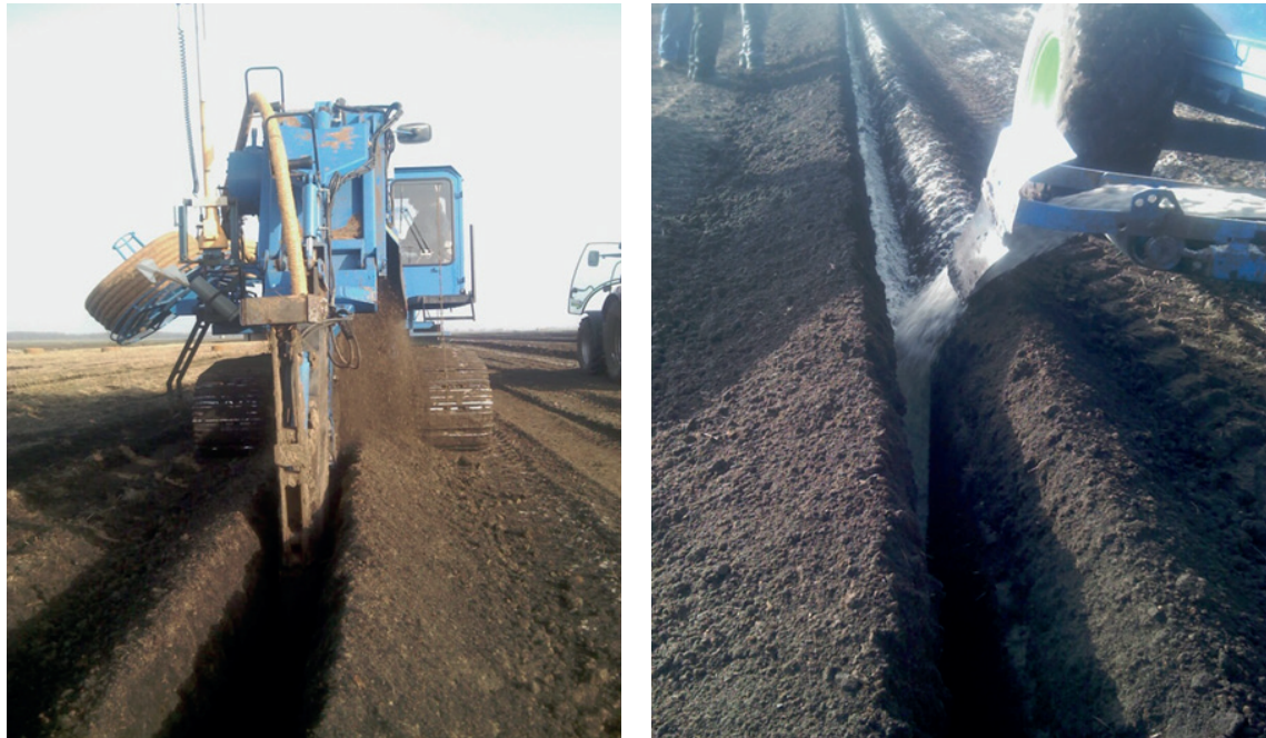
FIGUUR 2.3 AANLEG VAN DE DRAINAGE. LINKS: DE DRAINEERMACHINE GRAAFT DE SLEUF EN LEGT DE DRAIN ERIN. RECHTS: DE SLEUF WORDT GEVULD MET GOED DOORLATEND ZAND.
