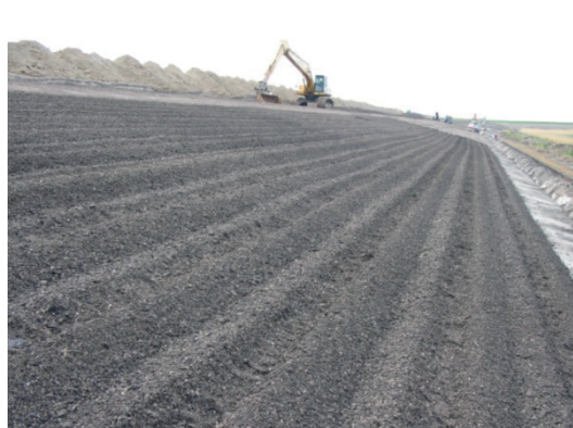
FIGUUR 25: GEFREESDE ASFALTBEKLEDING INCLUSIEF 20 Á 25 % ZAND
