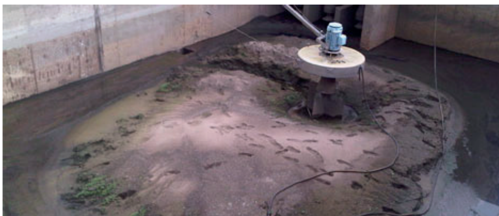
AFBEELDING 1.1 VOORBEELD VAN EEN TANK MET BEZONKEN ZAND (1)
