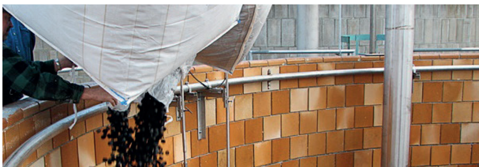
AFBEELDING 3.3 TOEVOEGING VAN DRAGERMATERIAAL AAN ACTIEF-SLIBPROCES (HEADWORKS INTERNATIONAL)
